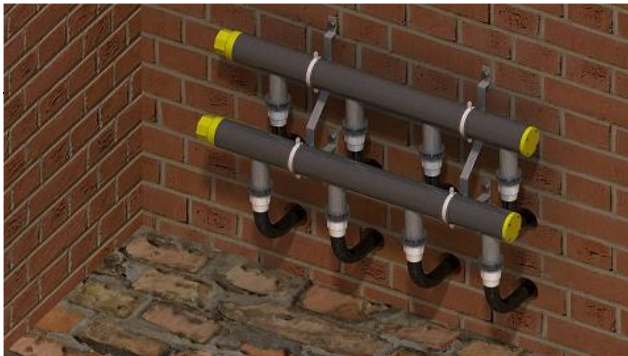
v.b. 4-groeps verdeler in technische ruimte (kelder)
